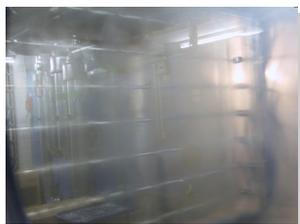
La stazione di pompaggio di humiFog è dotata di un inverter e di un sistema di atomizzazione multi-stage in modo da ottenere un ampio range di modulazione. Il BMS (building management system) può chiedere ad humiFog di generare qualsiasi portata d'acqua nel range 47...246 kg/h ottenendo così un preciso controllo delle condizioni dell'aria all'interno dell'edificio. L'acqua spruzzata viene da un impianto ad osmosi inversa in modo da ridurre drasticamente la manutenzione dell'umidificatore.
